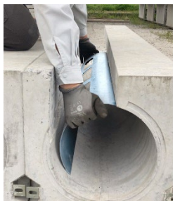
施工中の様子
